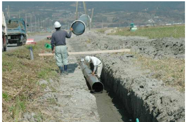
着々と進む配管敷設工事→
