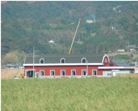
洒落たデザインの揚水機場(工事中)
