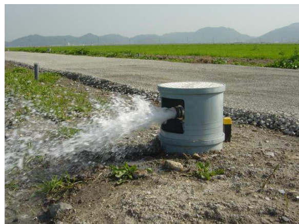
通水試験に伴う給水栓からの放水
