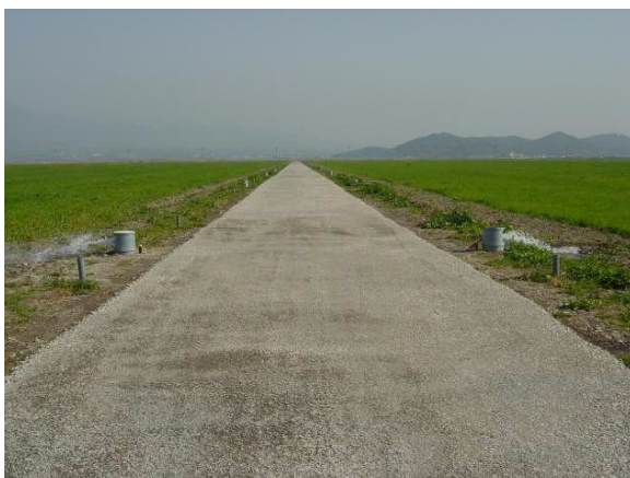
ほ場沿いの耕作道路に設置している給水栓
