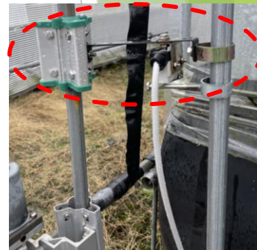
写真1 CO 2 換気連動施用に用いたECO2スイッチ(赤枠内)
