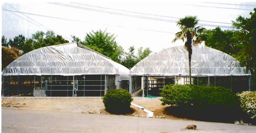
パイプハウスを利用した低コスト牛舎として畜試に建設した実証展示施設
