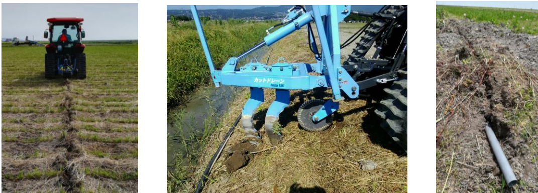
写真7 ー左 カットドレーン施工後の圃場表面の様子 ー中 排水路側の土手からカットドレーンを入れる ー右 カットドレーンの出口に塩ビ管をを入れて補強する
