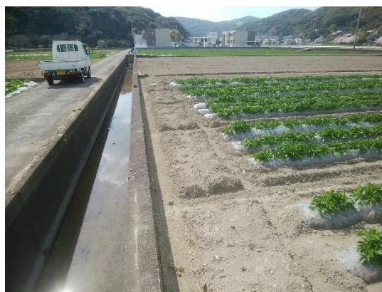
写真 19 圃場内の小排水溝は外の排水路に水が流れるように設置している (愛野 2019年4月3日撮影)
