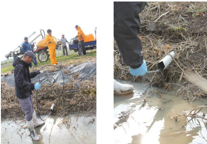
写真5 動力噴霧機を活用した暗きょ清掃の様子
