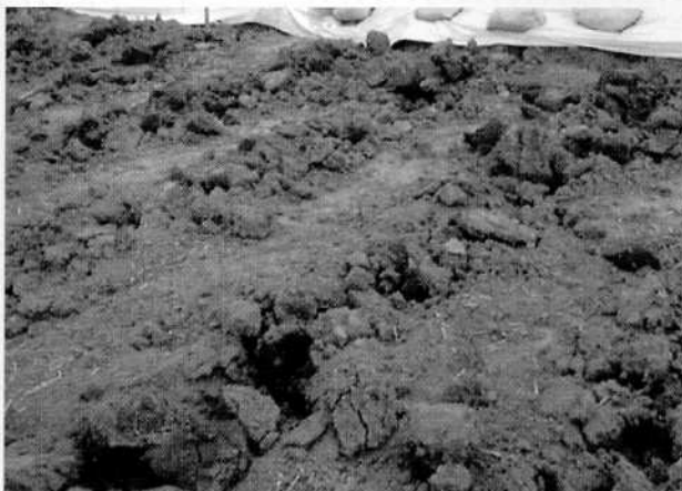
写真9 弾丸暗きよの施工跡
