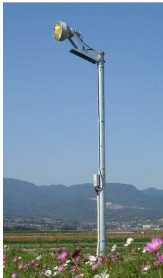
図1 黄色高圧ナトリウムランプ (270W)使用の黄色灯 ※高さ 5m、水平方向に設置
