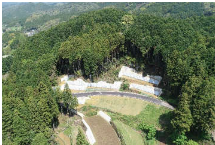
林道災害復旧事業による復旧状況（波佐見町）
