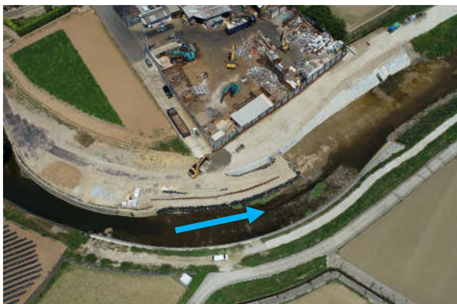
江ノ浦川河川改修工事（改修状況）
