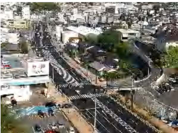
横道工区の供用状況
