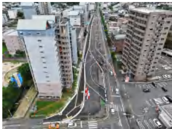
大神宮工区の工事状況
