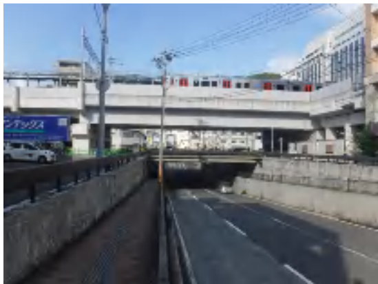
国道202号稲佐立体交差部の現況
