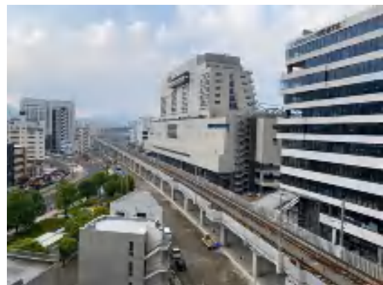
完成した高架線路と長崎駅東通り線の施工状況
