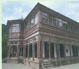
旧鹿児島紡績所技師館 鹿児島県
