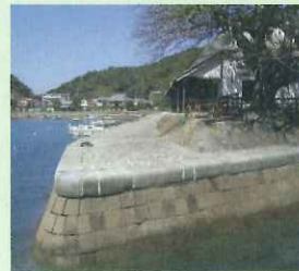
三角西港施設 熊本県
