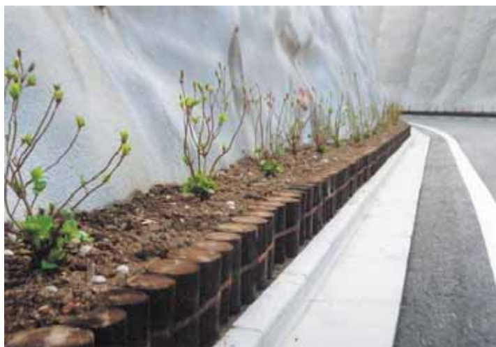
路側修景施設工 施工状況
