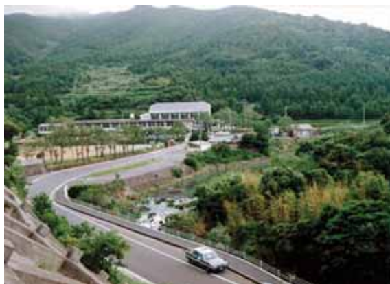
整備実施前全景
