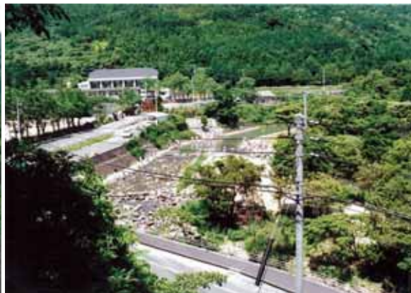
整備実施後全景
