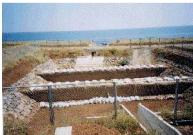
沈砂地を上流側から望む
