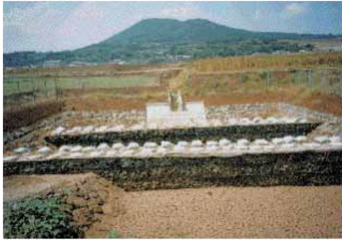
沈砂地を下流側から望む
