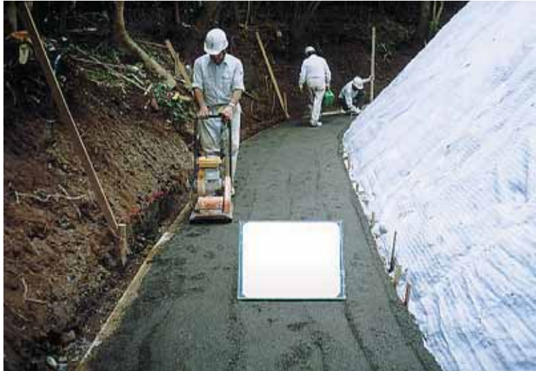
舗装材の締め 固め状況
