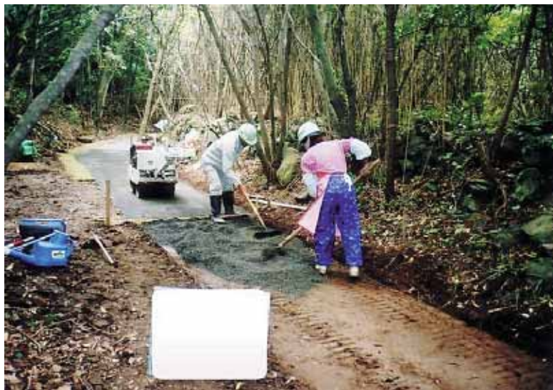
舗装材の敷き均し状況
