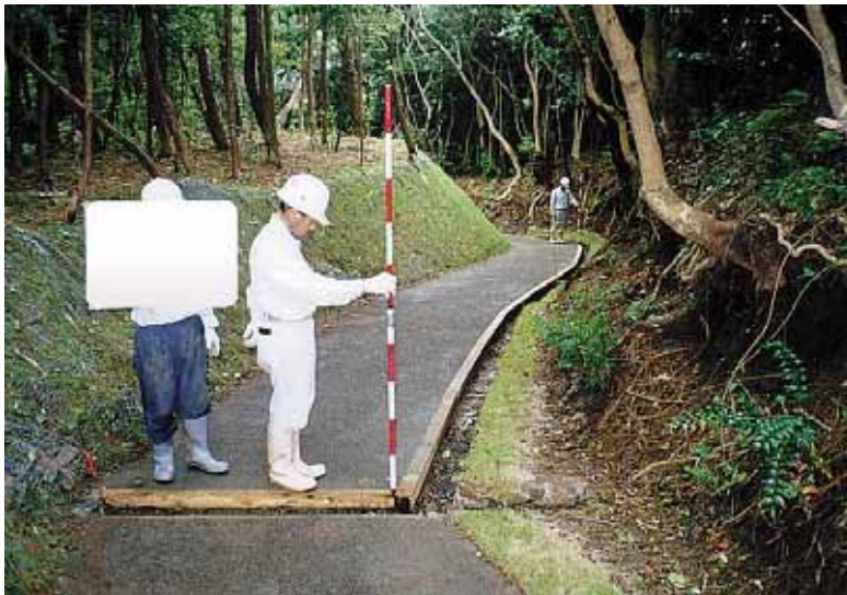
舗装工事の 完成状況
