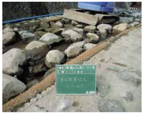
施工中（置石設置状況）
