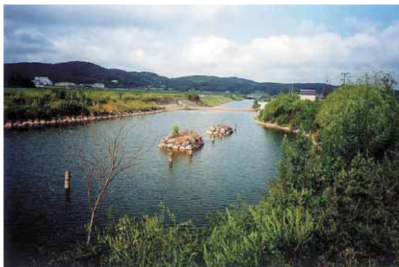
現在の状況：法面に草木が繁茂している(H16.8)
