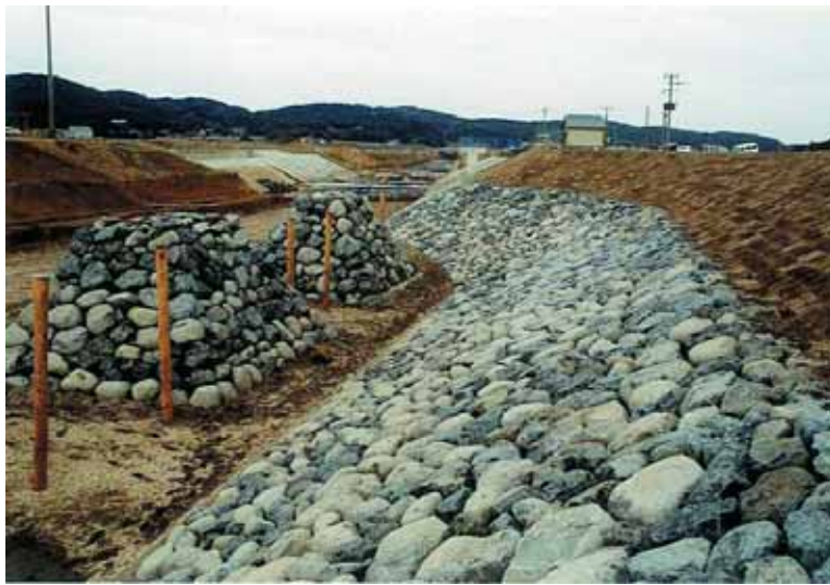
うなぎ等の魚巢となるよう配慮し空石積みで施工する(H11.12)
