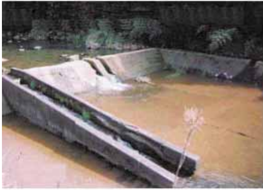
写真1 第一堰（施工前）
