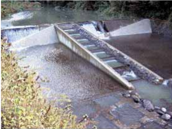
写真4 第一堰（施工後）
