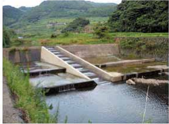
写真5 第四堰（施工後）
