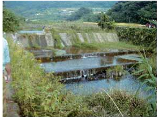
写真2 第四堰（施工前）
