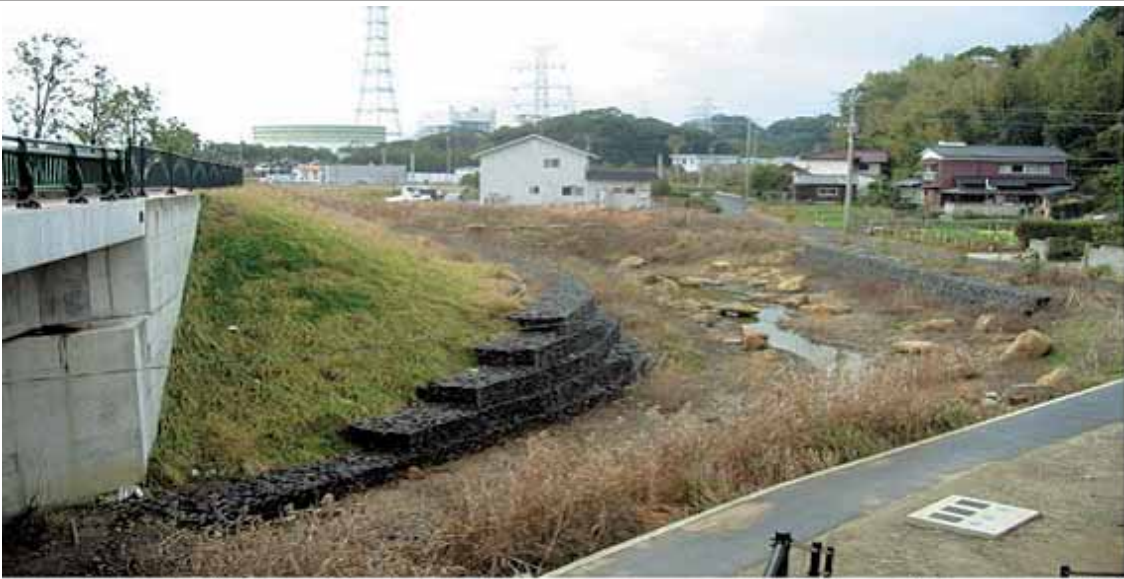
写真－４ 橋梁・盛土・ビオトープ（下流より）
