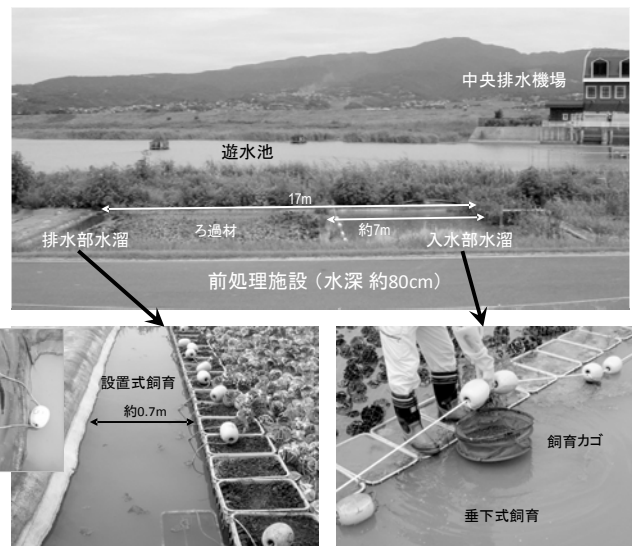
図 4 中央遊水池実験施設内 前処理施設概要
