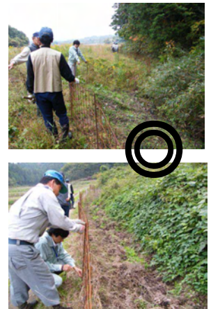
▲見回りと補修を同時実施
