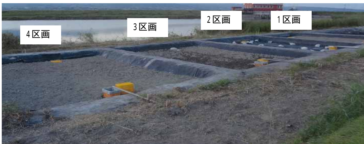
a) 土壌浸透浄化施設全景
