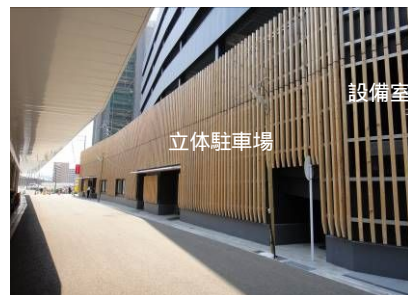
立体駐車場を目立たなくした例(大分駅) 立体駐車場の低層部に地場産杉材をルーバー状に取り付けることで、外から設備や車両等が目立たなくなるように工夫しています。
