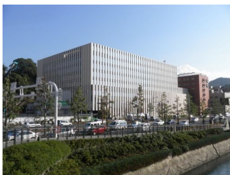
建物のボリューム感低減の例 (長崎市新地町) 垂直方向に分節化したファサードとすることで、長大な壁面の圧迫感を軽減しています。
