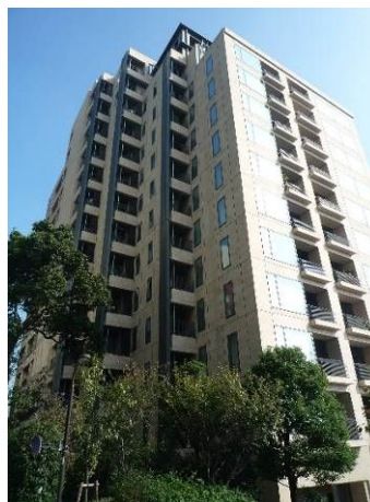
建物外壁の分節の例 (東京都千代田区・内藤廣氏(設計)) 外壁の凹凸と壁面や窓部の色彩の使い分けによって高層マンションの威圧感を軽減しています。
