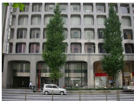
建物のボリューム感低減の例 (東京都銀座・前川國男氏(設計)) 低層部にヒューマンスケールの回廊を配置することで、オフィスビルの単調さを軽減しています。
