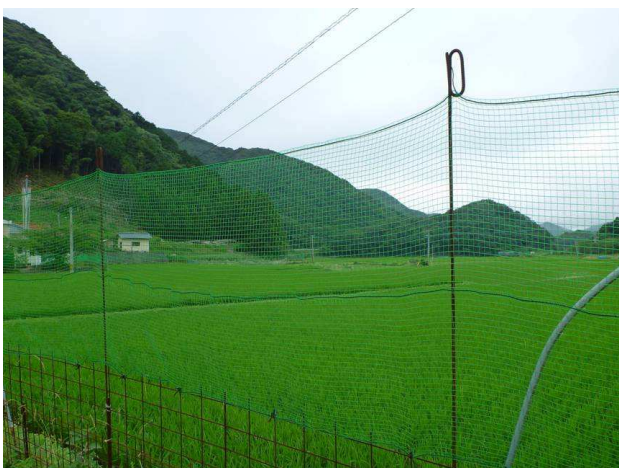
▲ワイヤーメッシュ柵の上部にネットを取り付けた複合柵（対馬市）
