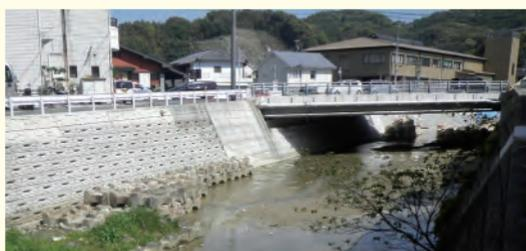
川幅を拡げるための護岸改修と古川橋の架け替えが完了(平成28年3月)
