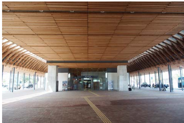
【日向駅自由通路天井（杉材）】
