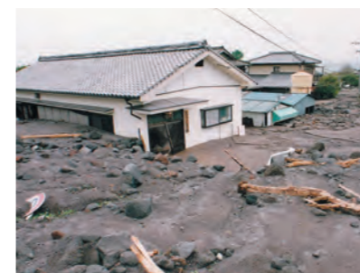
水無川被災状況
