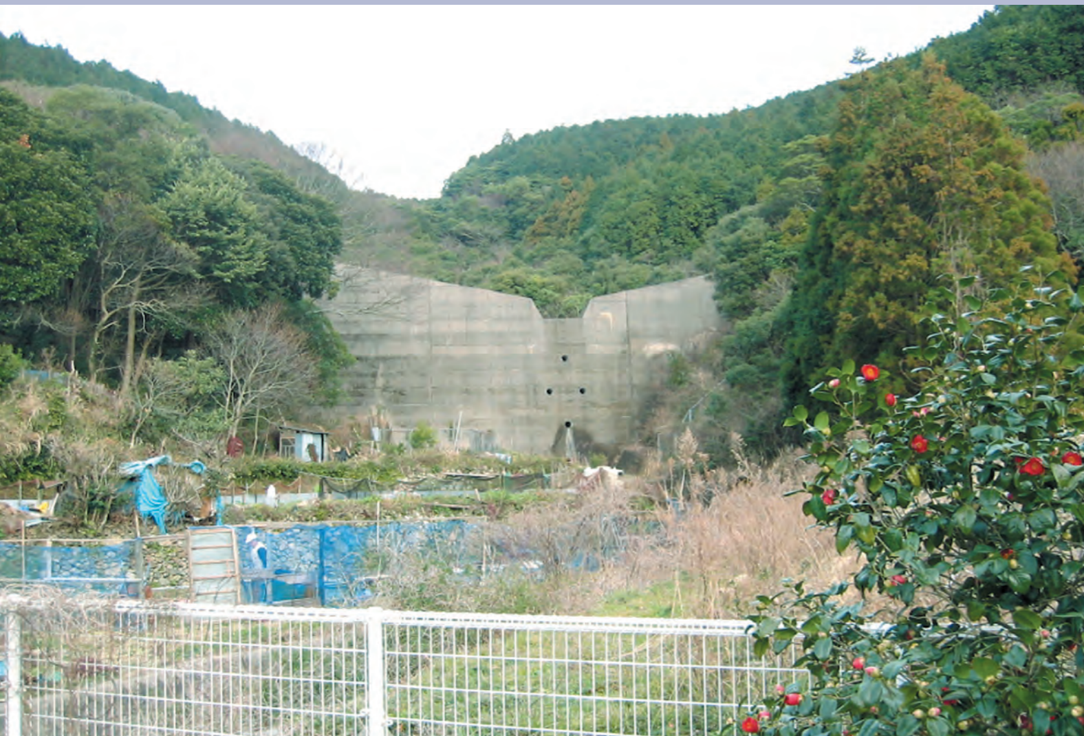
善田川災害関連緊急砂防事業(新上五島町)
