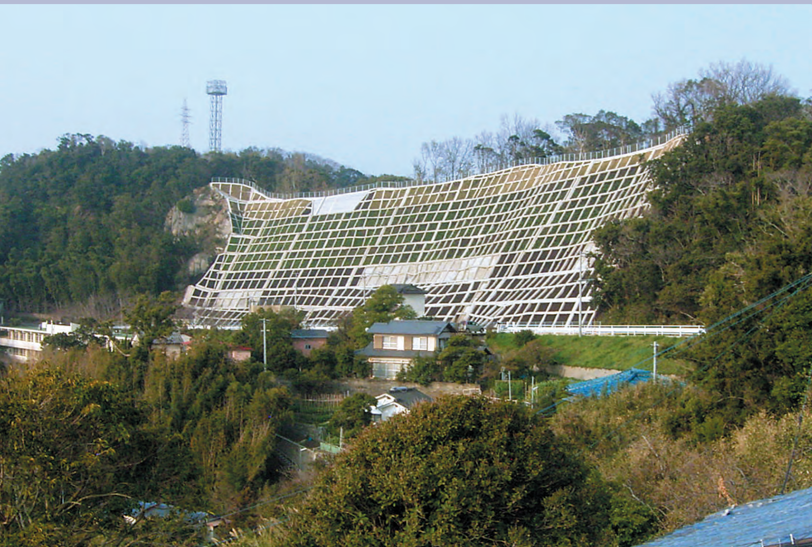
香焼地区 頭部排土工
