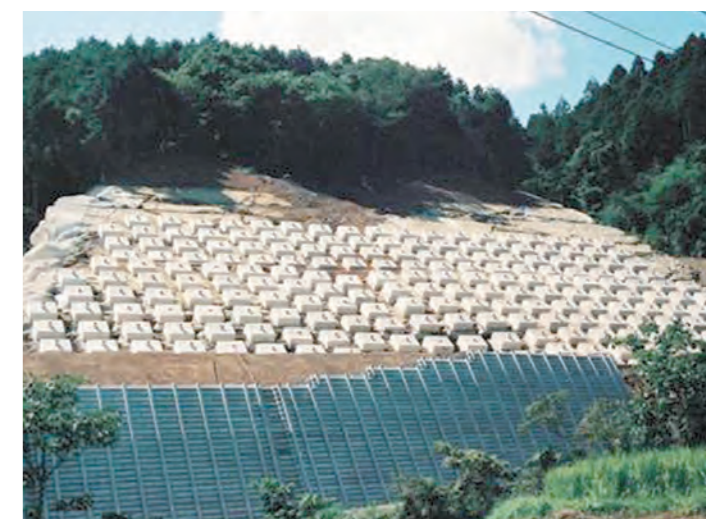
鷲尾岳地区 アンカー工
