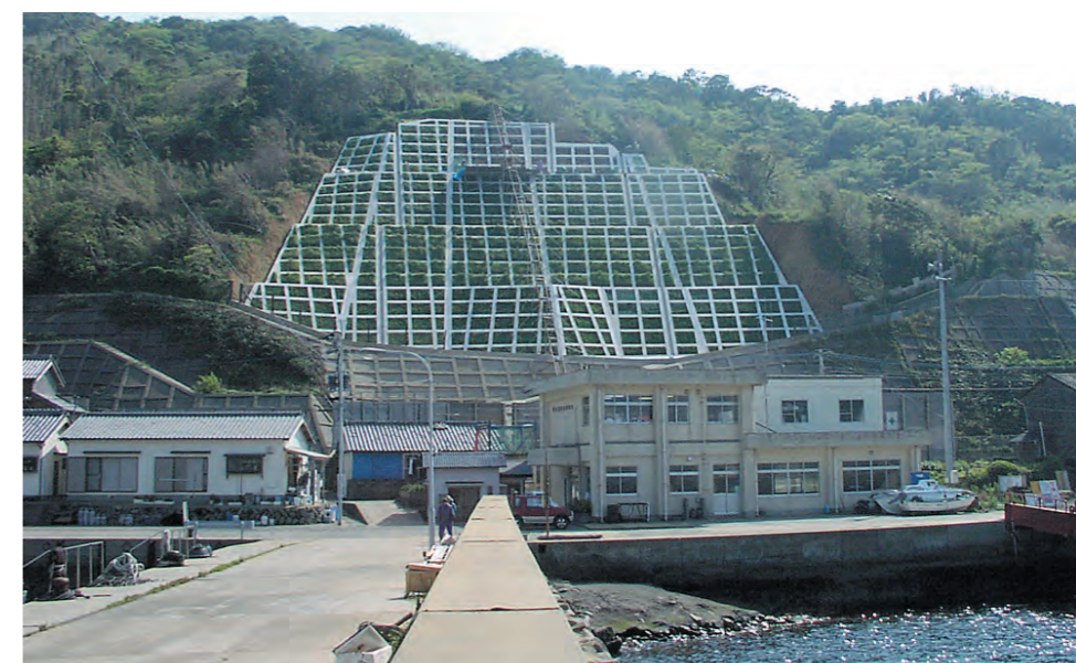
伊福貴地区災害関連緊急急傾斜地崩壊対策事業(五島市)
