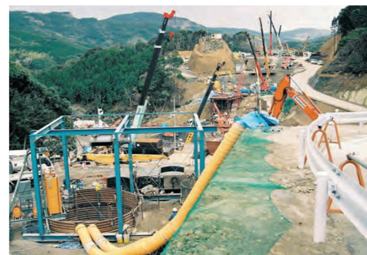
鷲尾岳地区 深礎杭工
