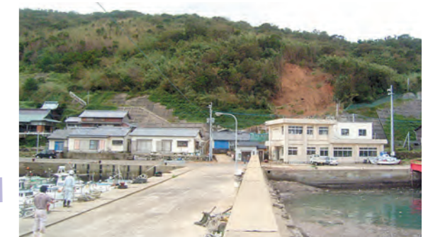
被災直後の状況
