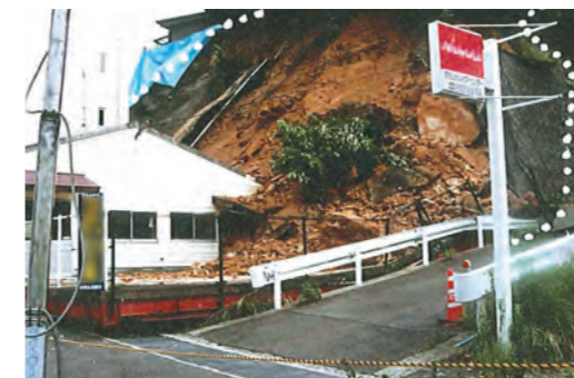
被災直後の状況
