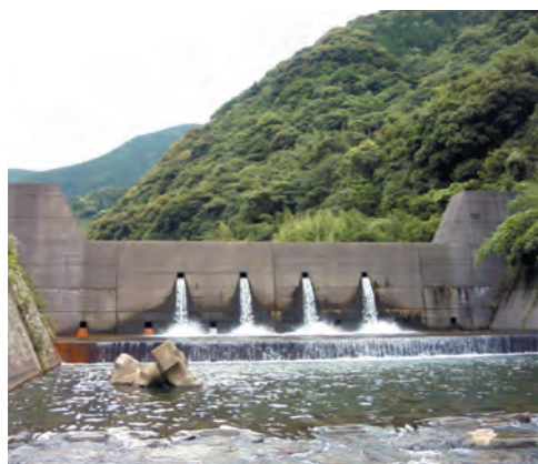
施工前の状況
