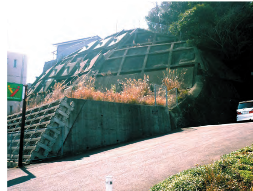
日野地区災害関連緊急地すべり対策事業(佐世保市)
