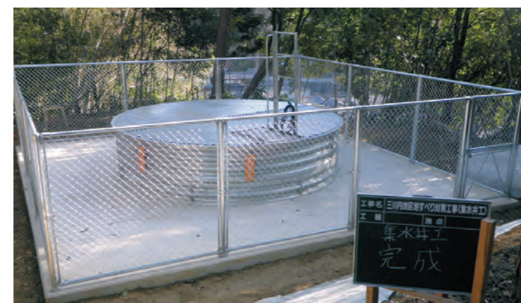
三川内地区 集水井工
