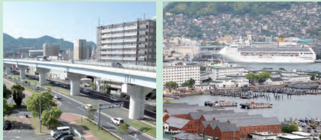
整備が進む西九州自動車道
