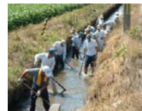
水路の泥上げ
