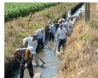
水路の泥上げ
