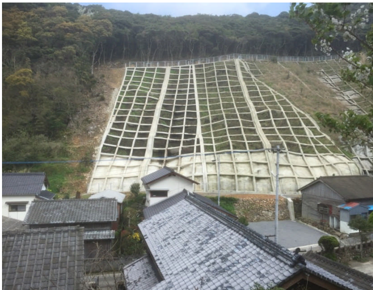
東平地区急傾斜地崩壊対策工事（平成22年度から平成31年度まで）
