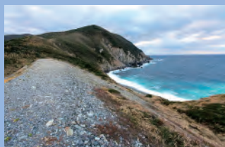
野首浦の防風堤 奈留島の絶景スポットの一つで、延命寺トンネルの建設工事に出てきた土砂を積み上げて作られた五島市奈留町大串地先 ☎0959-64-3117(奈留支所)
