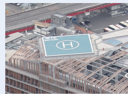
新県庁舎屋上のヘリポート
