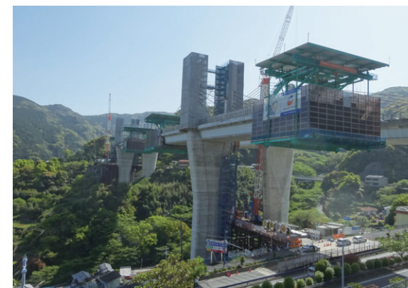
日見夢大橋の工事の状況
