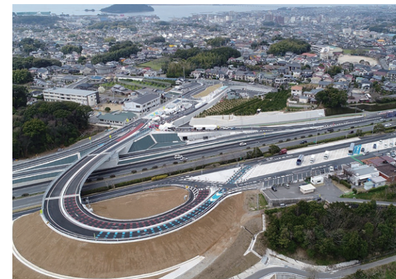
開通した木場スマートICの様子
