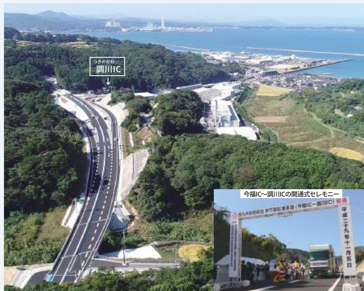
高規格幹線道路 西九州自動車道(調川IC付近)
