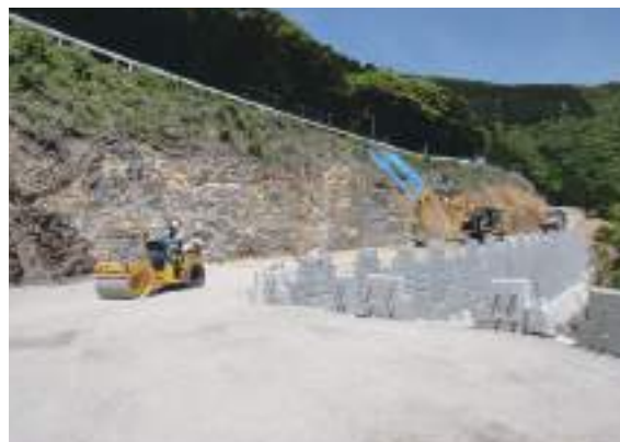
(主)厳原豆酸美津島線(尾浦～安神工区)工事の状況
