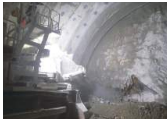
(仮称) 久留里トンネル工事の状況(時津工区)
