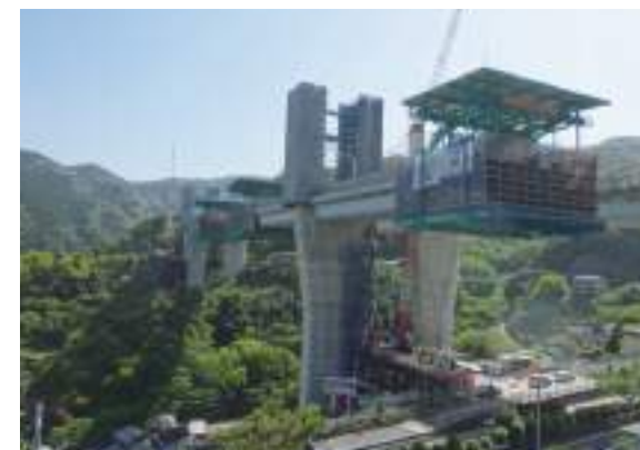
日見夢大橋の工事の状況
