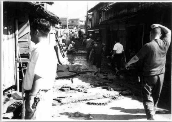
水は引いたものの、泥道となり長靴は必要であった
