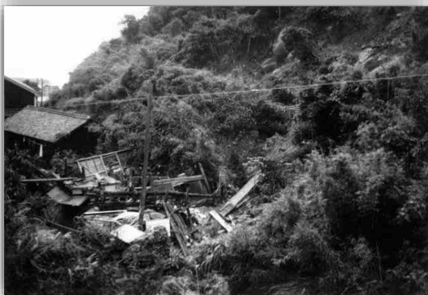
土石流被害にあった住宅
