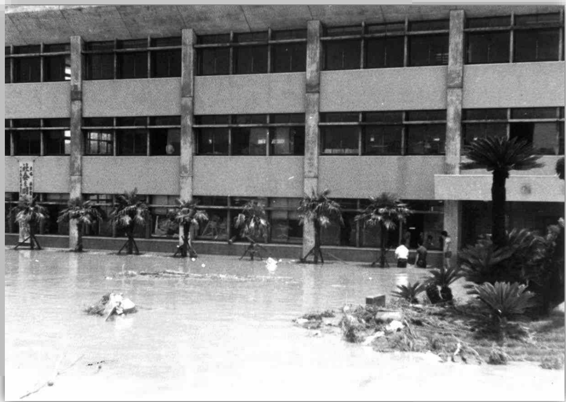
腰の高さまで浸水した五島市役所
