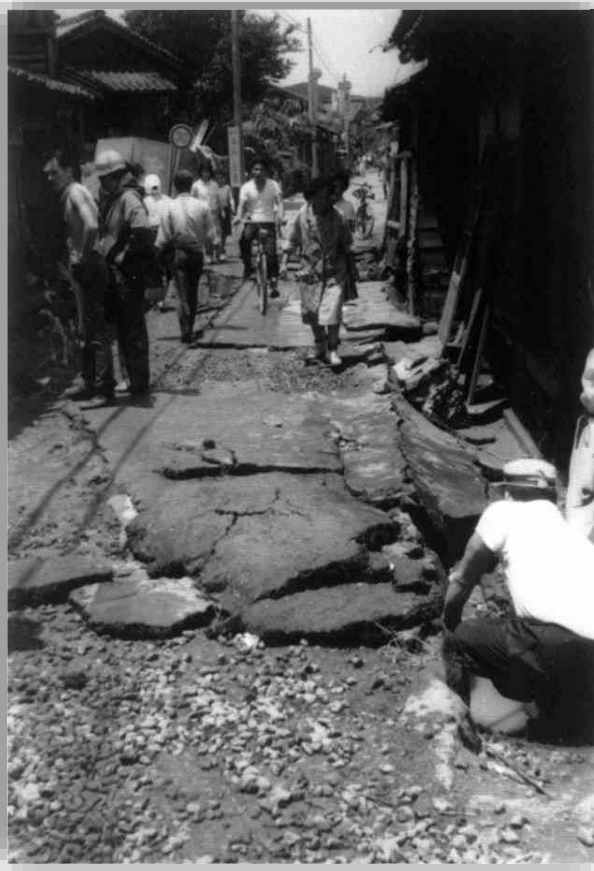
氾濫した水の力はすさまじく舗装も破壊されるほどであった
