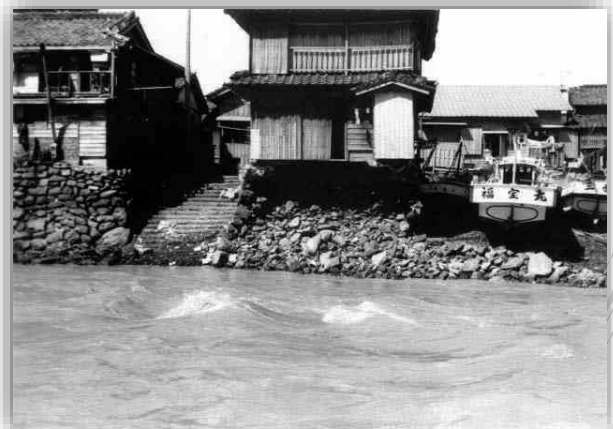
住宅は全壊を逃れたものの石垣は流出
