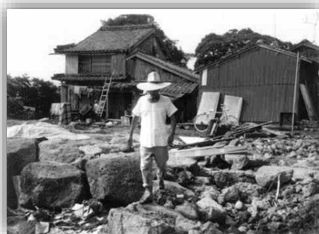
半壊した住宅
