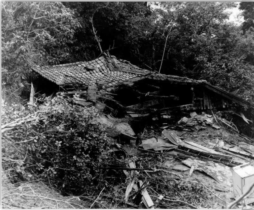
氾濫した水により1階部分が流出した住宅
