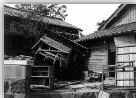
濁流の力で倒された建物
