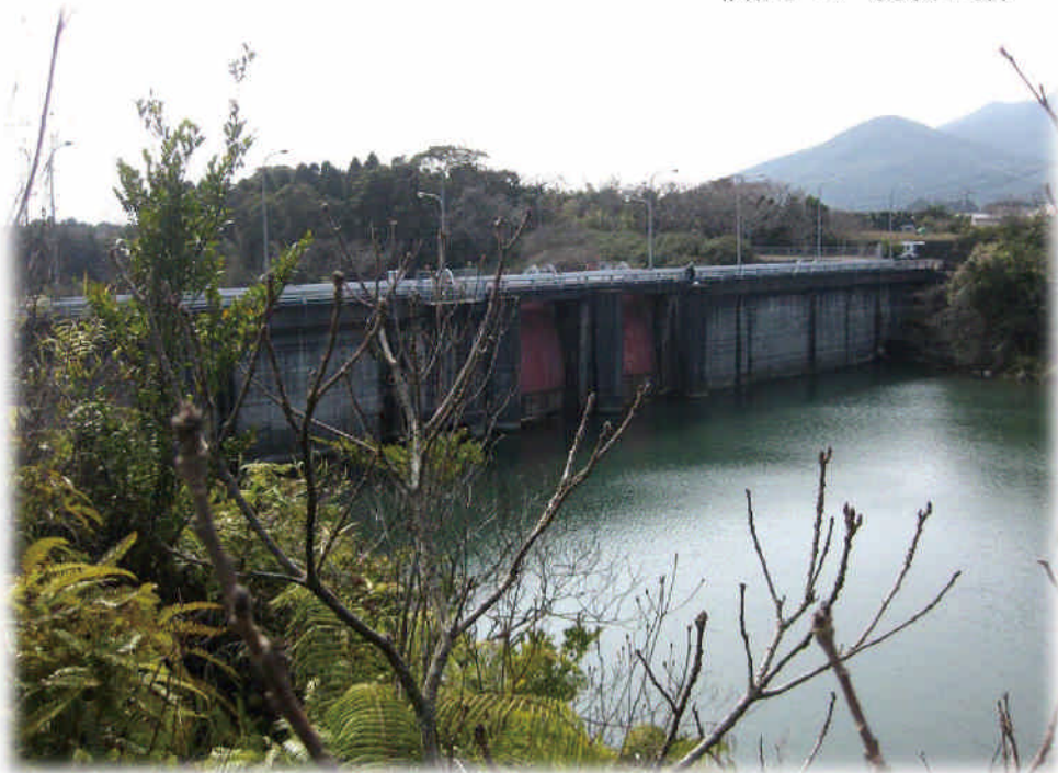
福江ダム 堤頂全景
