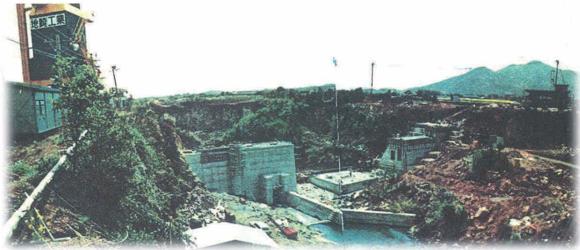
福江ダム堤体工事中
