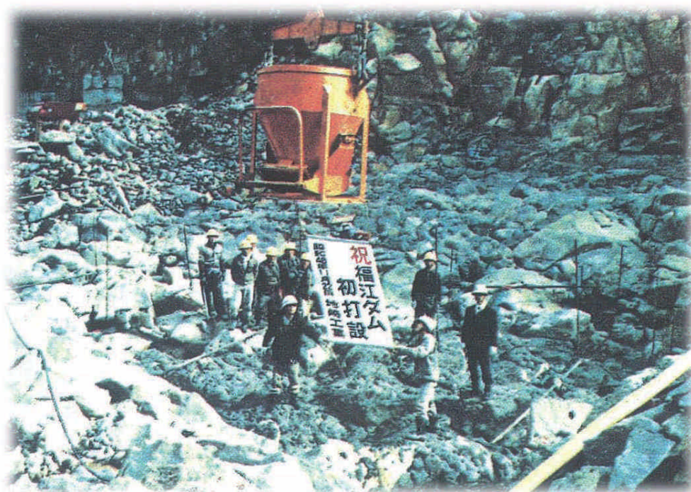
堤体コンクリート初打設
