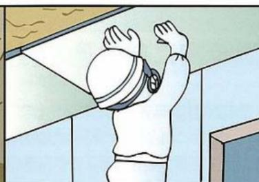
吹付けアスベスト等の層を残したまま、板状材料等で覆うことで、粉じんの飛散や損傷防止等を図る工法。
