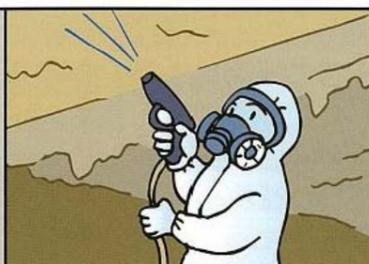
吹付けアスベスト等の層を残したまま、薬剤等を含浸したり、造膜材を散布し、吹付けアスベスト等を固定することで飛散を防止する工法。
