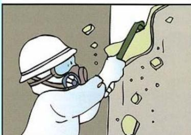
吹付けアスベスト等を下地から取り除く方法。アスベスト含有建材が完全に除去されるので、大地震の際にも剥落するおそれはなく、最も確実に建物を安全にする工法です。
