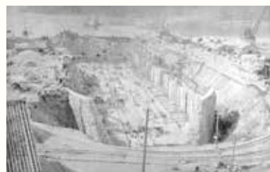
建造中の海軍工廠第一船渠
