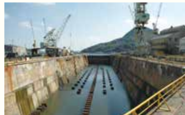
現第五船渠(旧第一船渠)
