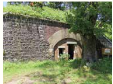
内部は上段の観測所と連絡が取れるようになっている
