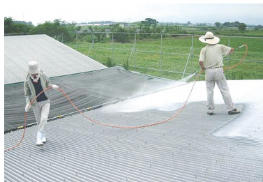
屋根への消石灰の散布
