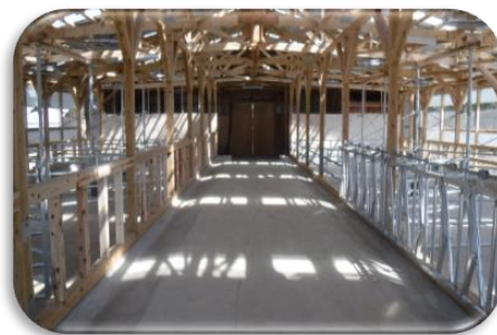
畜産クラスター事業の活用により整備した牛舎
