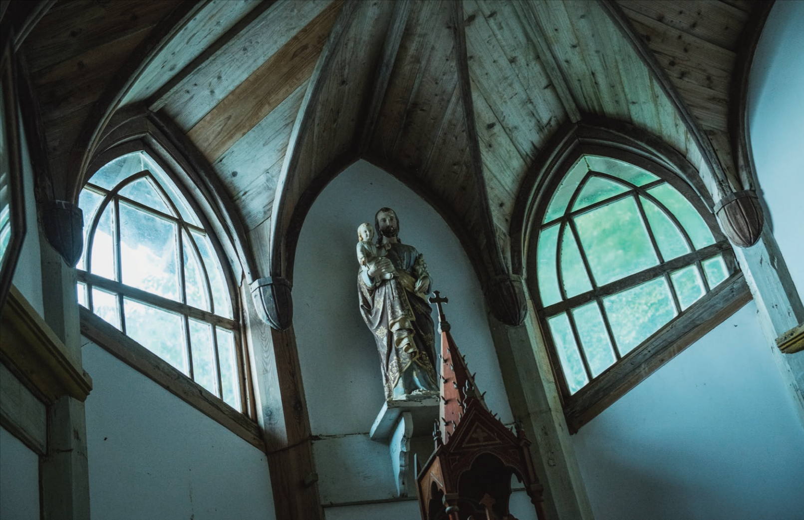
旧五輪教会堂は瓦葺木造ながらリブ・ヴォールト天井がある。初期の木造教会建築の代表例として、1999年に国の重要文化財に指定された。
