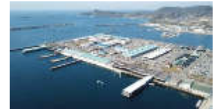
閉鎖型荷捌施設(長崎魚市場)
