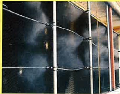
<クーリングパッドの設置>
