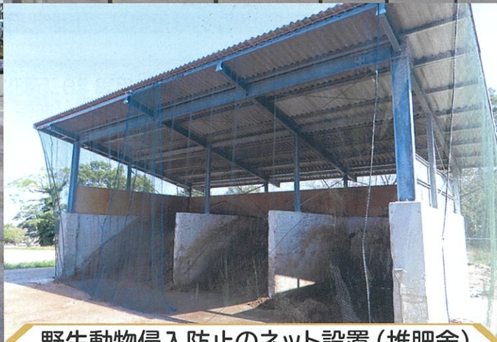
野生動物侵入防止のネット設置(堆肥舎)
