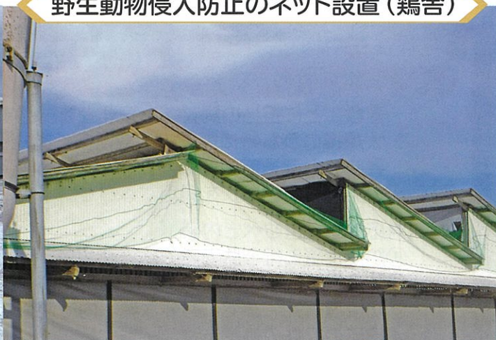
野生動物侵入防止のネット設置(鶏舎)
