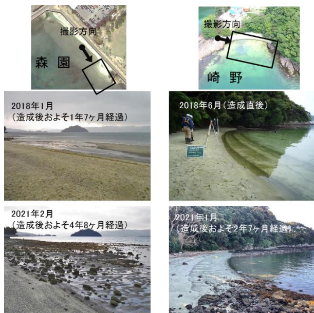
図 2a 森園(左列)および崎野(右列)における覆砂区の底面の推移。上空写真は Google Earth より引用。
