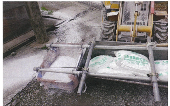
ホイローダーを利用した散布 (コンテナ底に網を張り散布量を調整)
