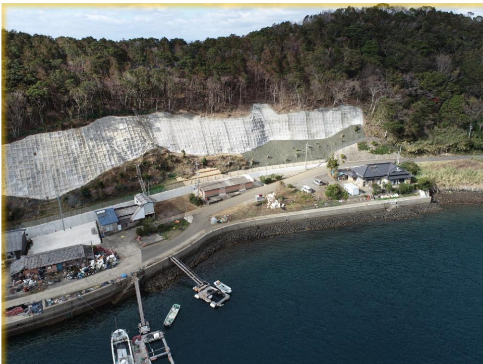
面高地区緊急予防治山工事
