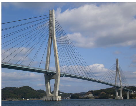
鷹島肥前大橋（松浦市・唐津市）
